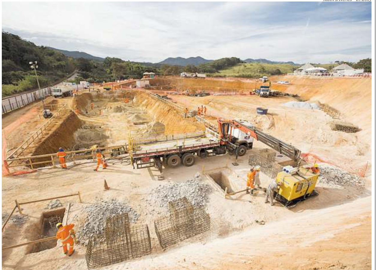
Abastecimento. Obra de captação da água do rio Paraopeba começou em julho, deve ficar pronta em dezembro e resolveria problema
